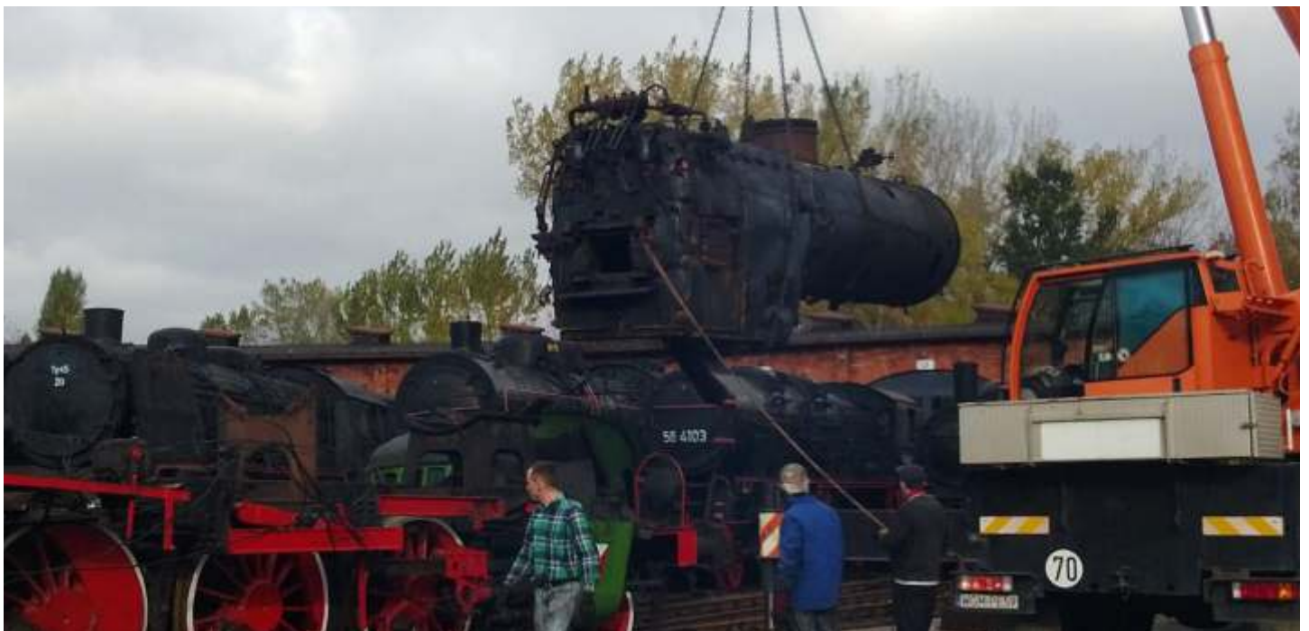
Demontaż kotła parowozowego w trakcie naprawy głównej w 2014 r.
