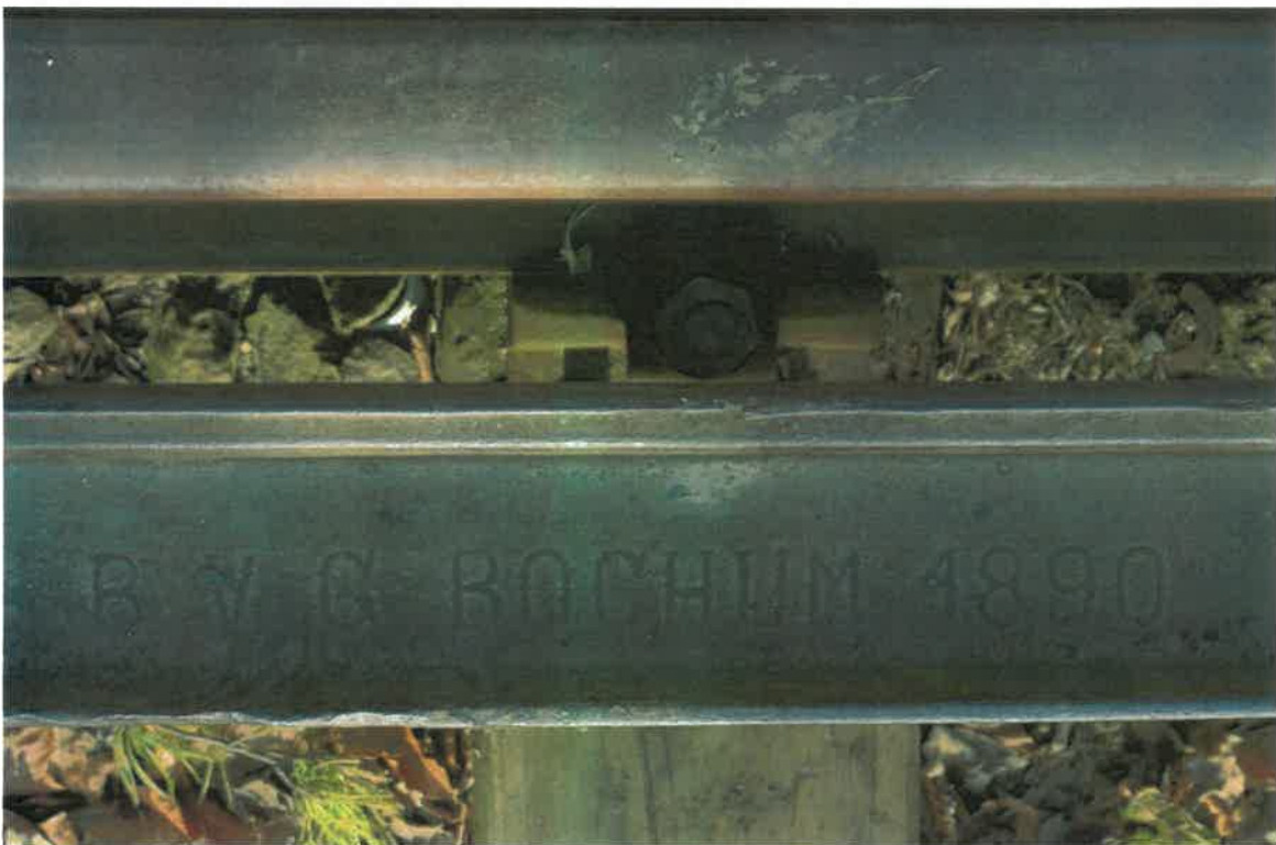
Most nad Jeziorem Pilchowickim. Na przyciółku północnym torowisko zostało wzmocnione ponownie użytą szyną kolejową z inskrypcją BVG BOCHUM 1890 . Fot. K. Czartoryski, 16.03.2020.
