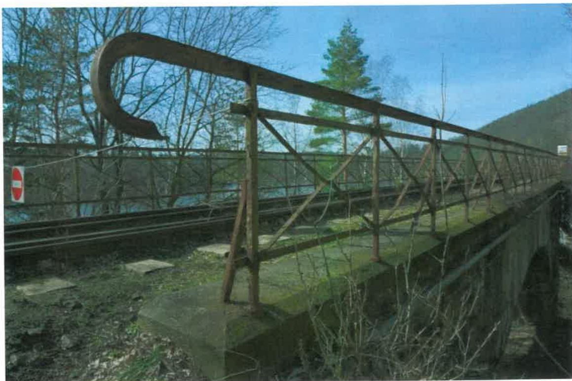
Most nad Jeziorem Pilchowickim. Opracowanie balustrady. Fot. K. Czarторыski, 16.03.2020.
