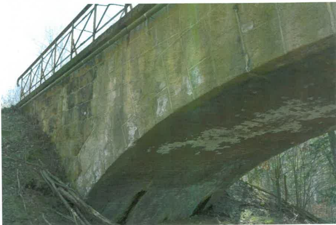
Most nad Jeziorem Pilchowickim. Sklepiony przyczółek południowy, czoło wschodnie, widoczne bloczki betonowe użyte do odbudowy po wysadzeniu w 1945 r. Fot. K. Czartoryski, 16.03.2020.
