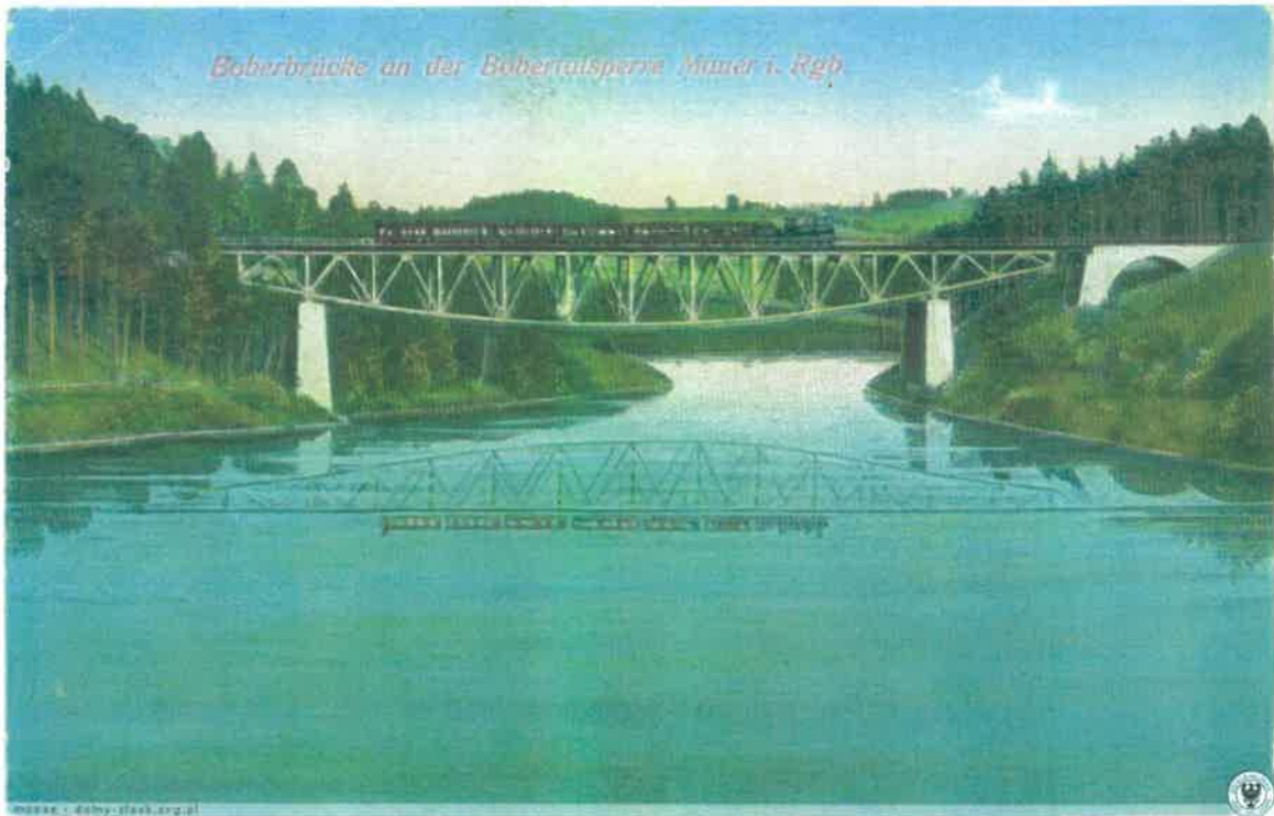
Most nad Jeziorem Pilchowickim, widok w kierunku wschodnim. Widoczny jest sklepiony przyczółek południowy. Pocztaówka kolorowana, po 1909 r. (źródło: polska-org.pl).
